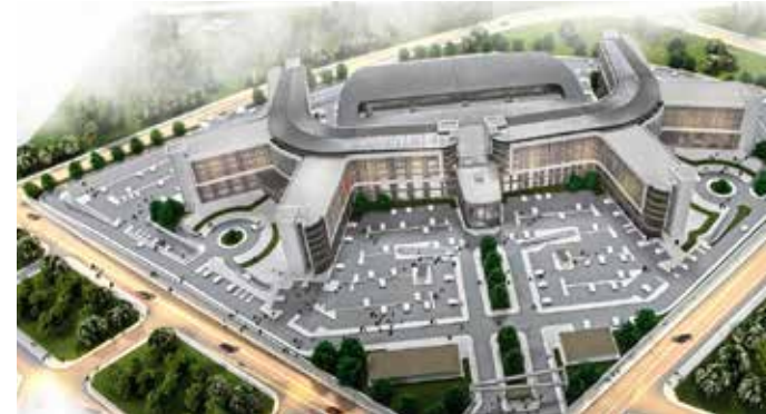
Mng İnşaat - Balıkesir Hastane Projeleri
